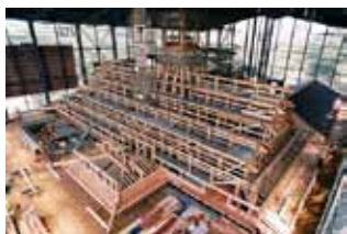
建築途中の奉行所（平成20年7月）
