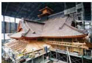
瓦葺きの完成（平成21年4月）
